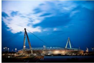
Toiture du Stade Juventus. Turin, Italie. Photo : avec la permission de Christian Nasset
